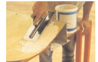
Foto 3a y 3b. Colocación de la cubierta
