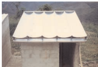
Foto 1. Vista parcial del Sistema de Techo
